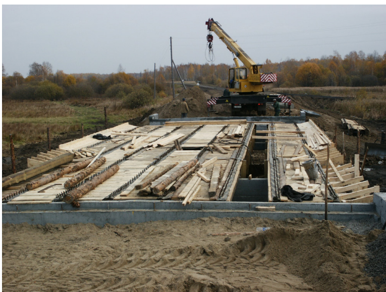
Рис. 9. Изготовление железобетонной плиты проезжей части (опалубочные работы и устройство нагельных соединений) Fig. 9. Manufacture of a roadway reinforced concrete slab (formwork and installation of dowel joints)
