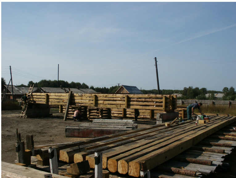
Рис. 8. Изготовление составных прогонов из бревен длиной 15 м Fig. 8. Manufacture of composite girders of 15-meter logs
