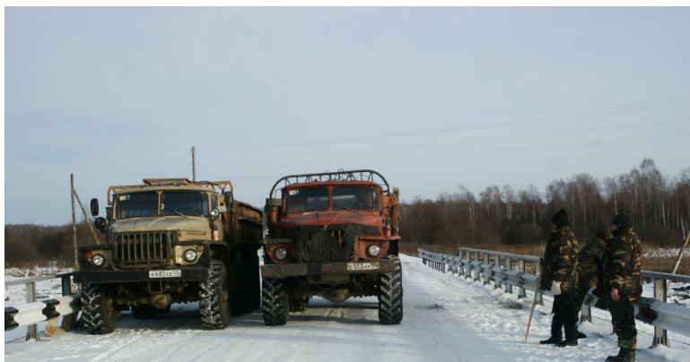
Рис. 16. Испытание моста через р. Нягов. Установка временной нагрузки
