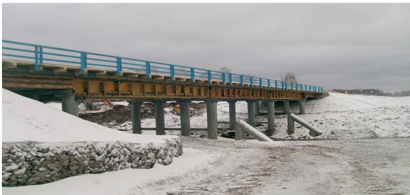
Рис. 11. Мост через р. Оша с 3 дощато-гвоздевными блоками в сечении 15-метровых пролетных строений
