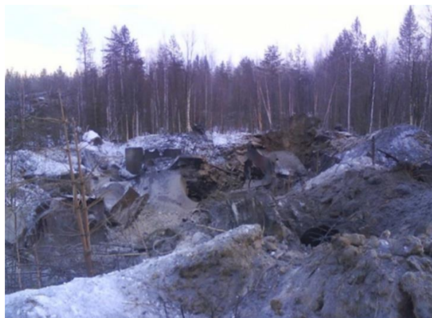
Рис. 2. ШПУ МБР РТ-2 после уничтожения методом взрыва
